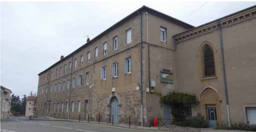
Lycée professionnel Saint Joseph sur l'emplacement de l'ancien couvent des Capucins.
