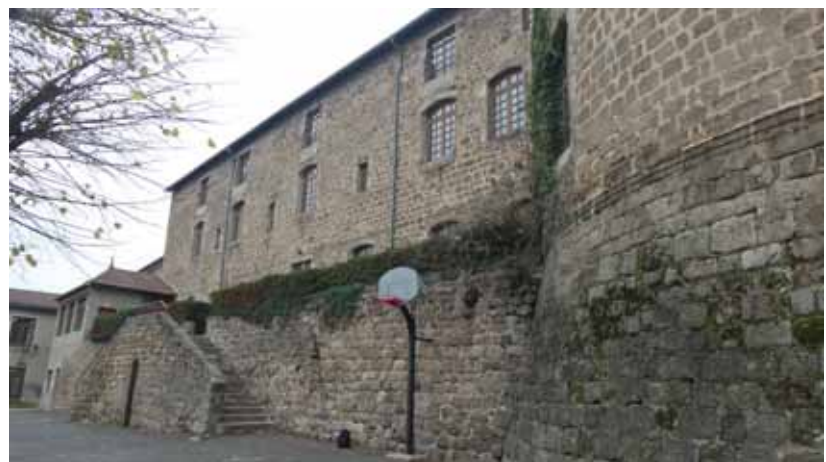
Château - Élévation Est
